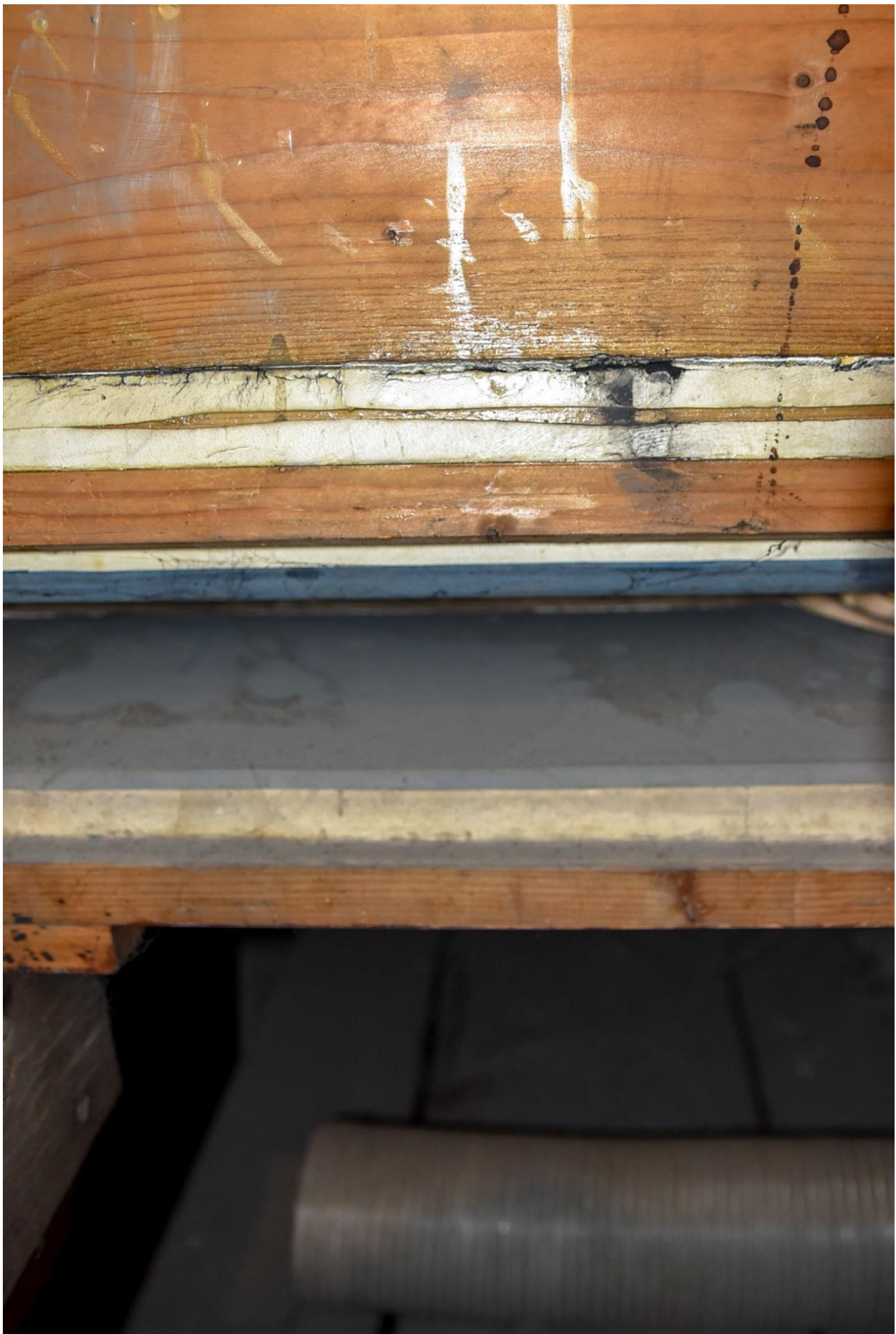
Fotografia 51 – oskórowanie nad klinowym podawaczem, widoczne zaczerzenie w miejscu powstania nieszczelności
