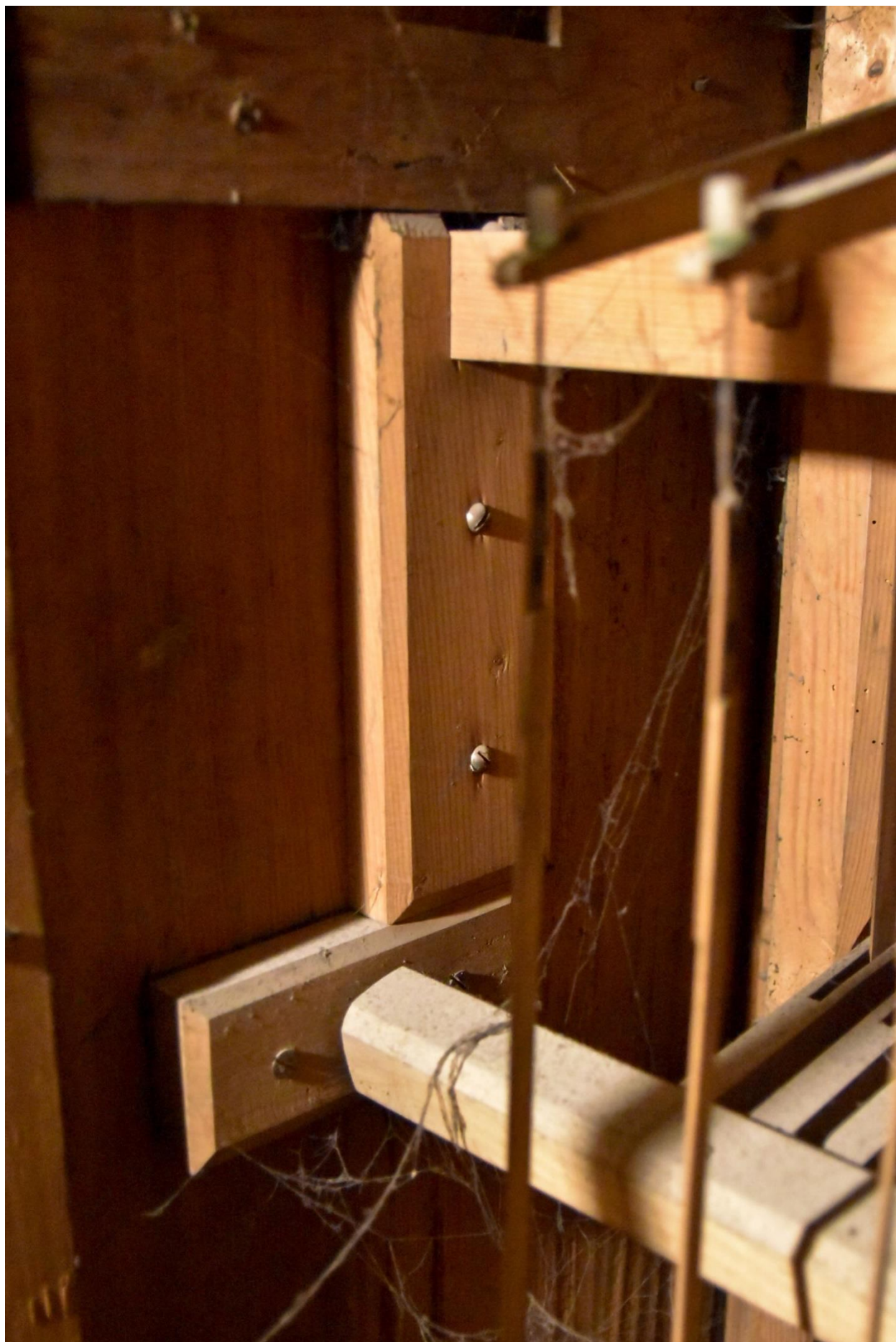
Fotografia 41 – oryginalny wspornik połączenia stołu gry i traktury mechanicznej, cechy konstrukcyjne pozwalają na odróżnienie sposobu obróbki drewna przez Żebrowskiego od warstwy powojennej
