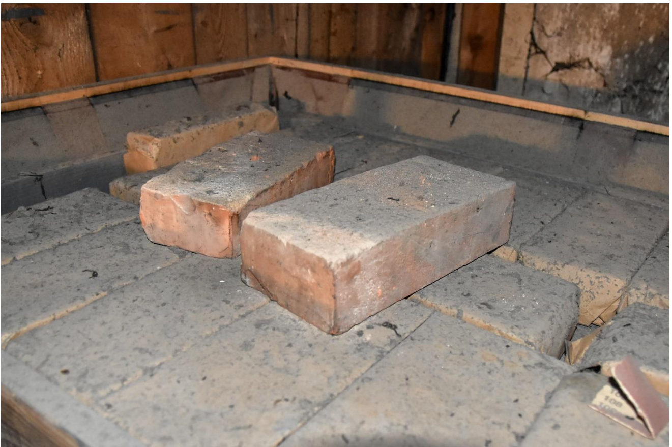
Fotografia 53 – obciążniki na miechu pływakowym w postaci cegieł opakowanych oraz nieopakowanych
