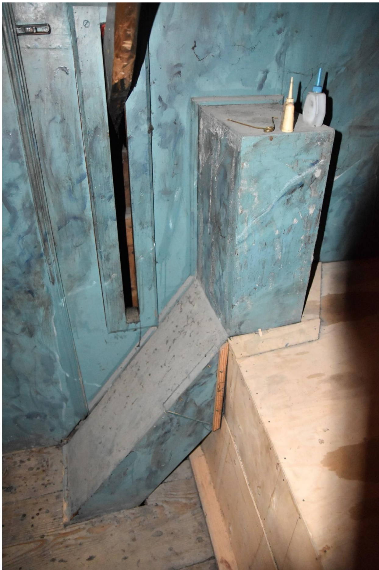
Fotografia 31 – kanał powietrzny ulokowany pod podłogą empyry organowej oryginalnie czerpał powietrze z pomieszczenia zlokalizowanego w ścianie północnej empyry
