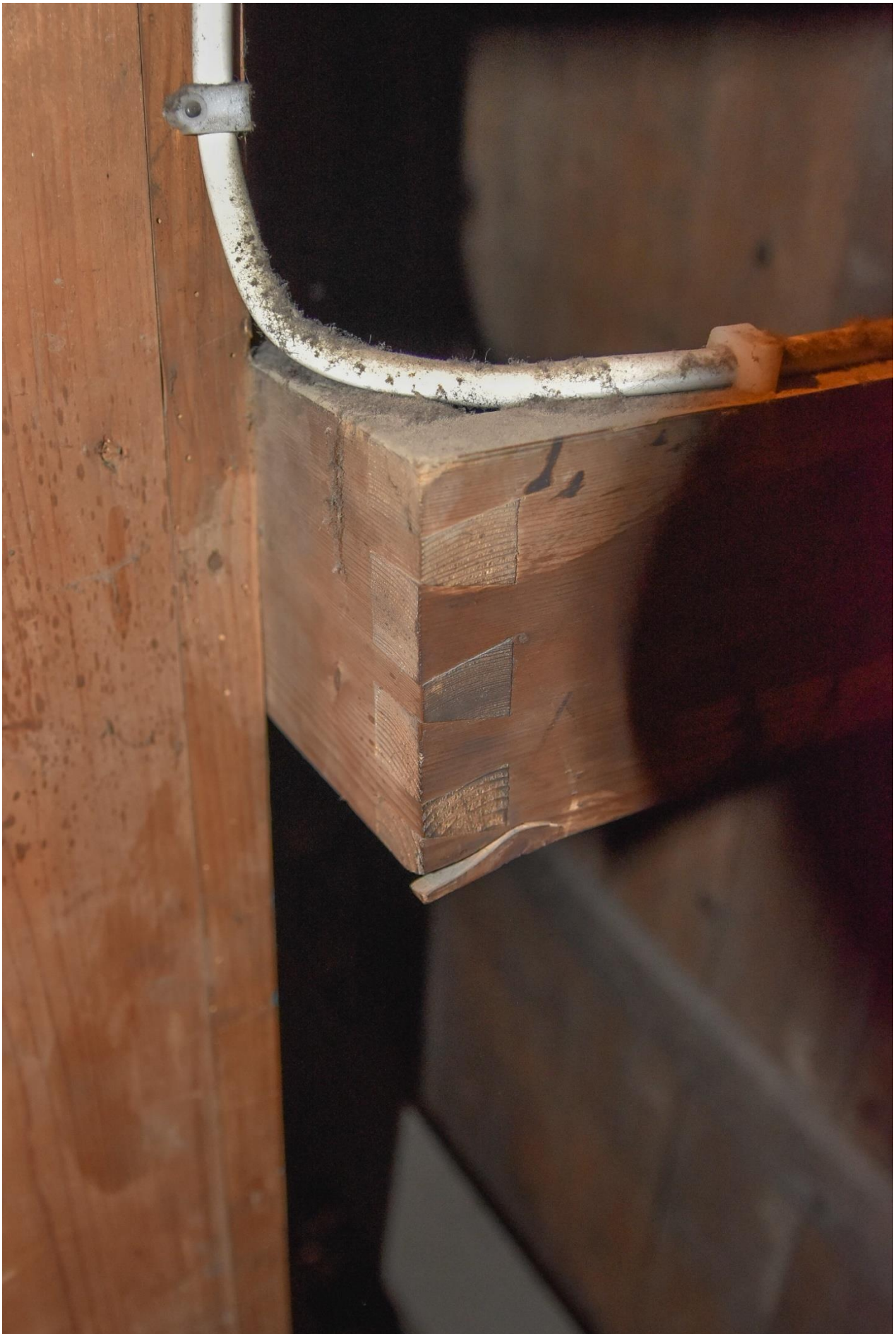
Fotografia 89 – tradycyjne połączenie dwóch elementów drewnianych za pomocą wczepu na jaskółczy ogon
