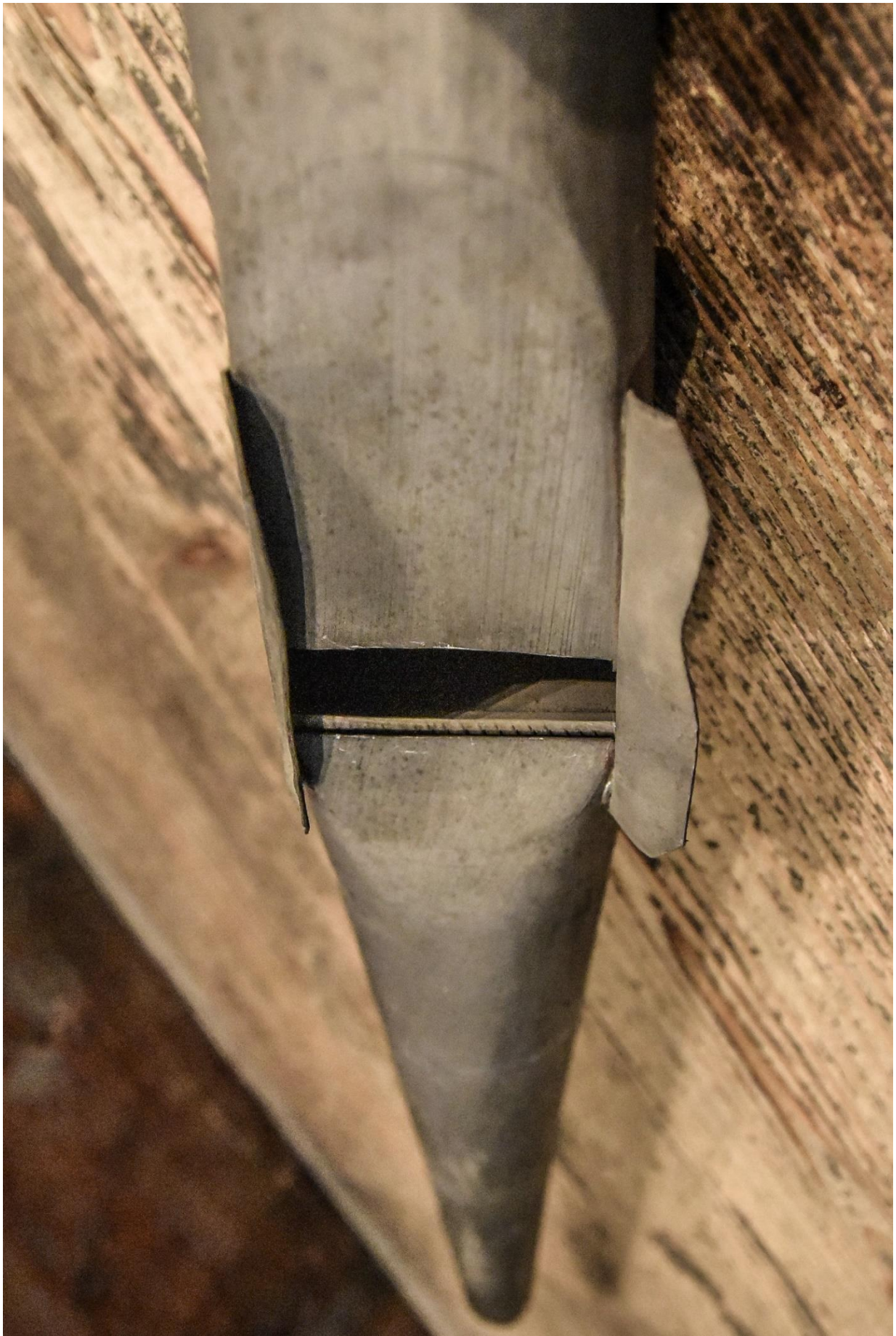
Fotografia 119 – ślady nierównomiernego nacinania rdzenia w metalowej piszczałce
