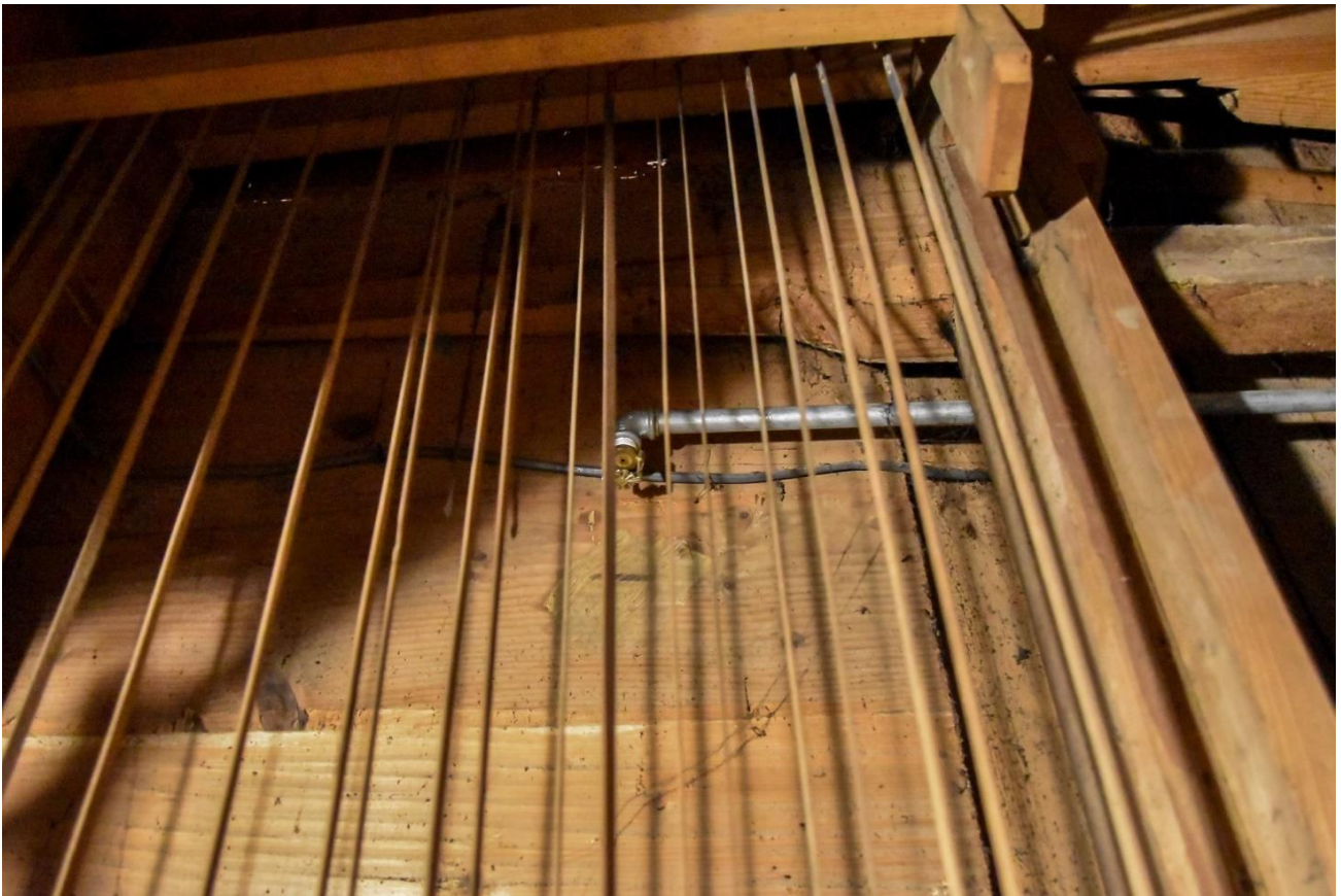
Fotografia 43 – element systemu stałych urządzeń gaśniczych na tle kabla elektrycznego, na pierwszym planie abstrakty
