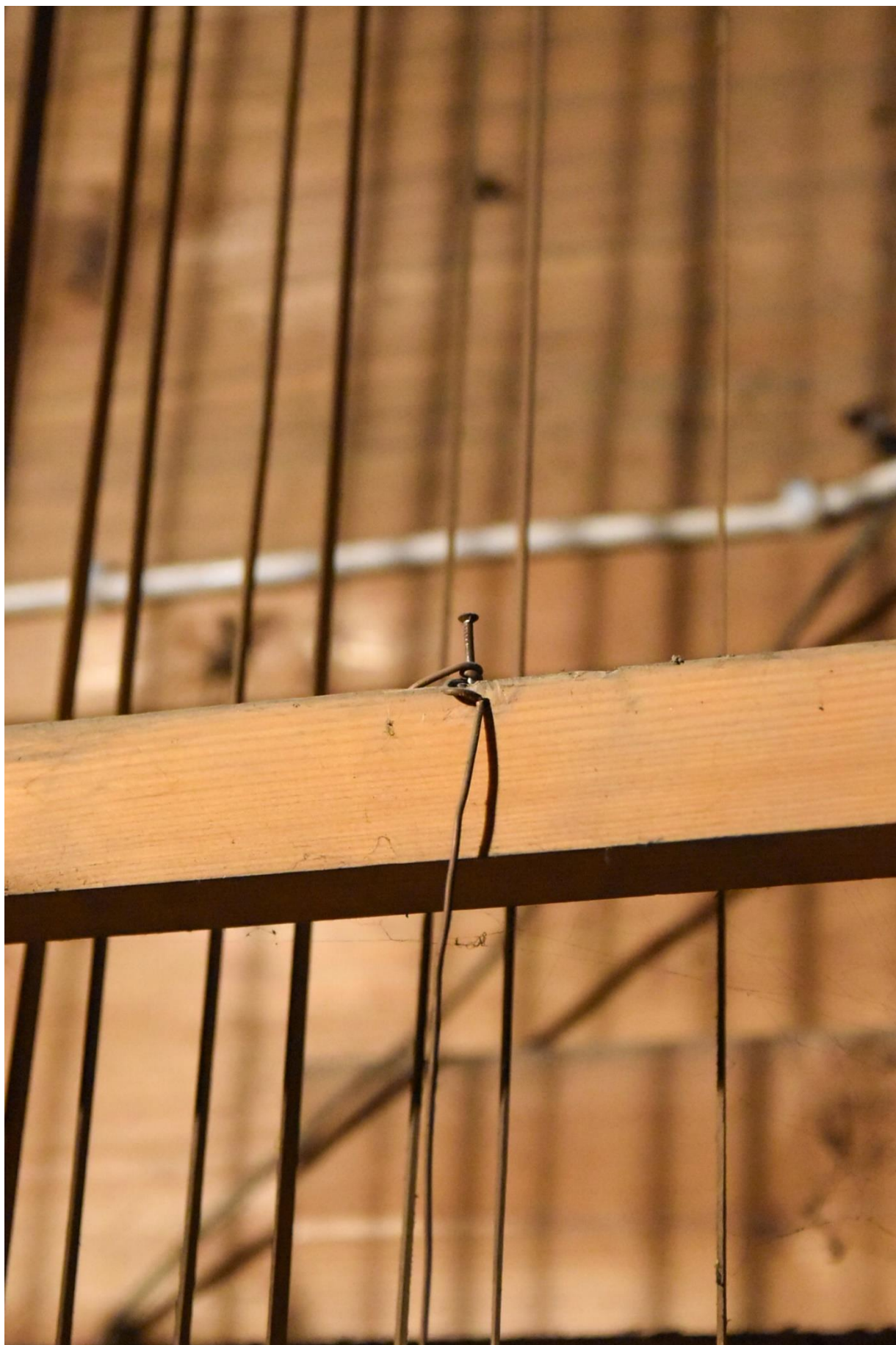
Fotografia 61 – prowizoryczne mocowanie zagiętego i wykrzywionego drutu na drewnianej listwie za pomocą krzywo i nie do końca wbitego gwoźdźcia świadczyć może o wysokiej kreatywności i fantazji osób działających we wnętrzu organów i nie stosujących profesjonalnych rozwiązań organmistrzowskich
