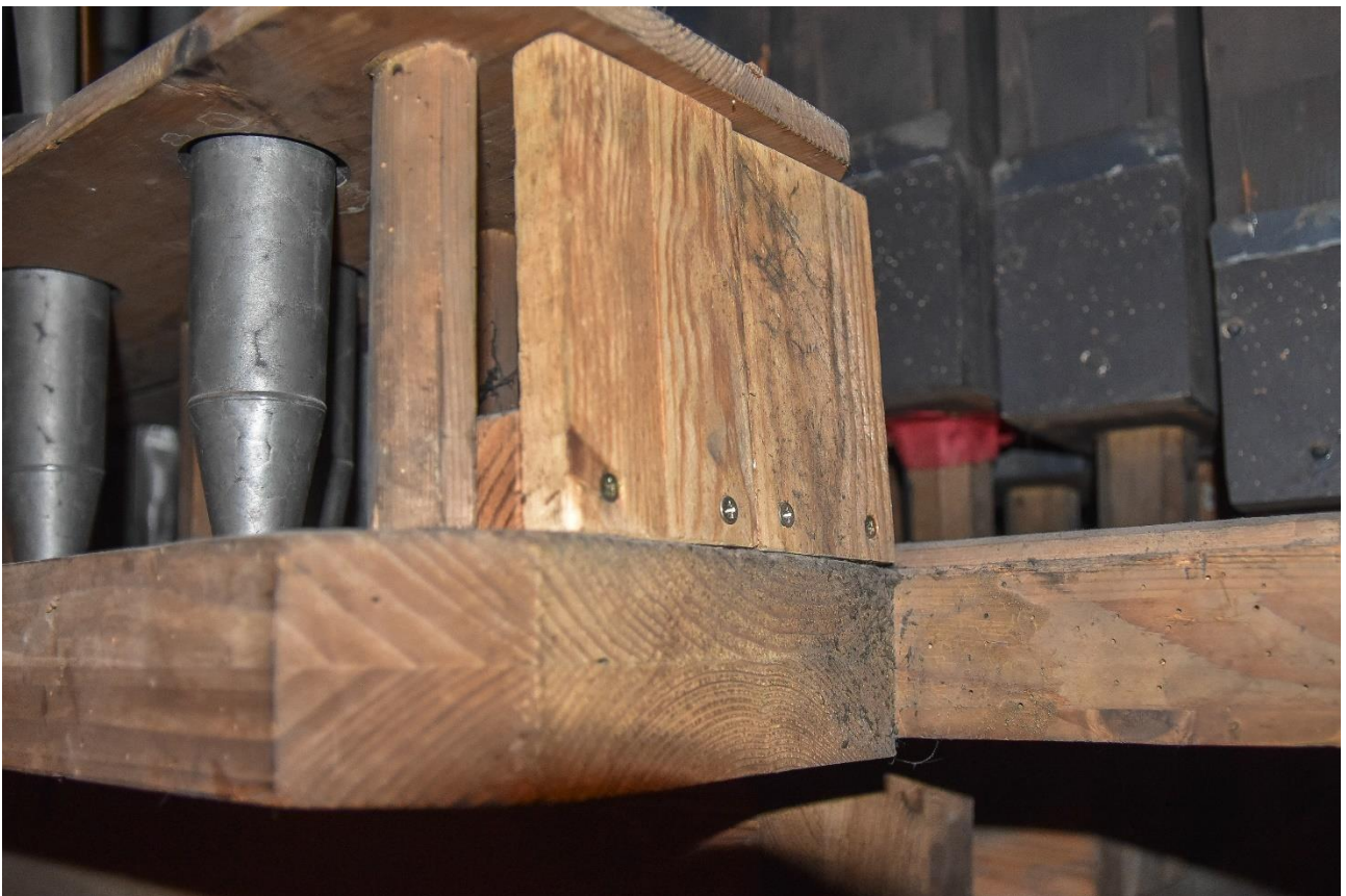
Fotografia 132 – chałupniczo wykonana stabilizacja ławeczek kłoca Bombardonu 16
