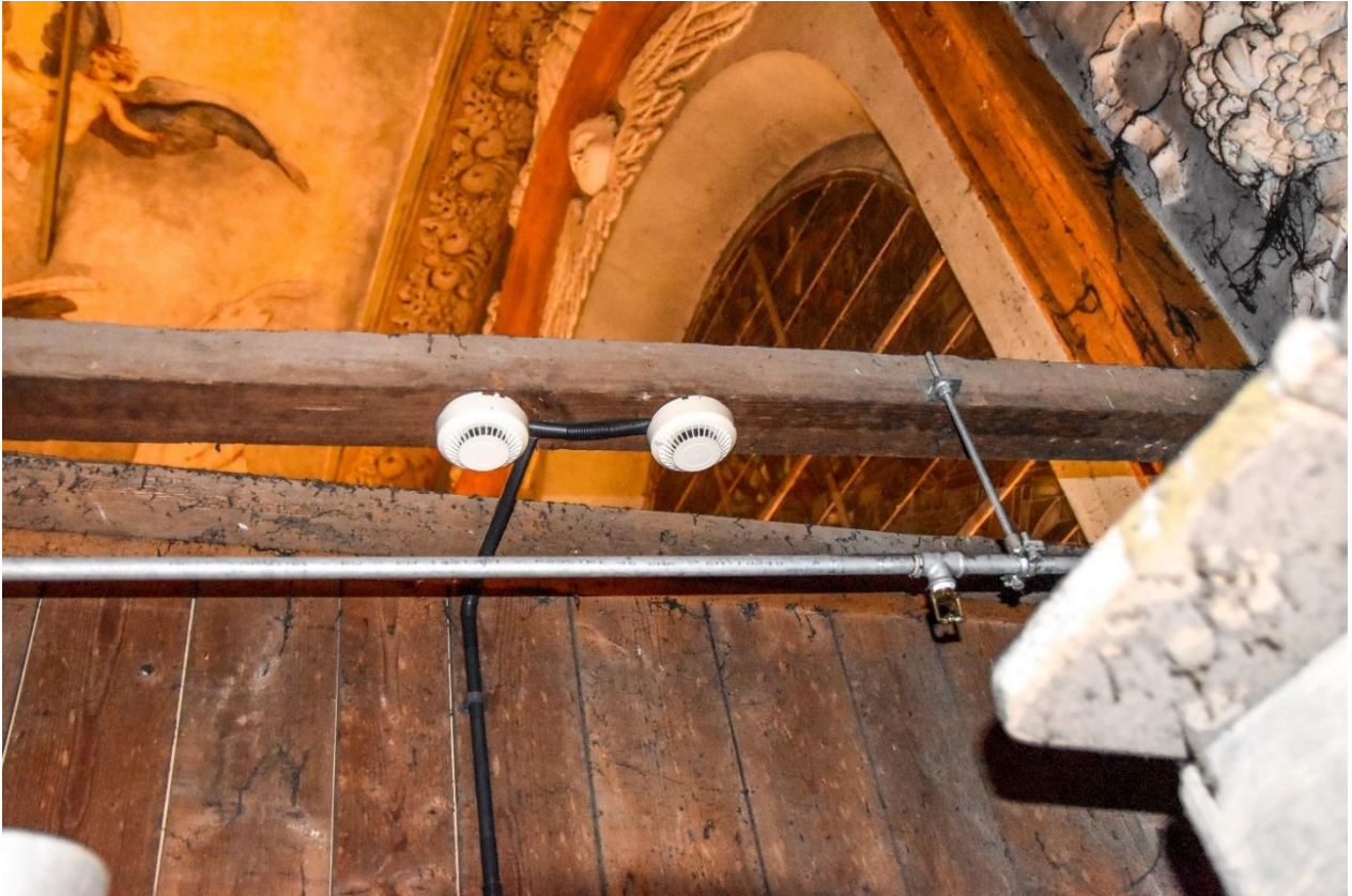
Fotografia 86 – czujki systemu przeciwpożarowego
