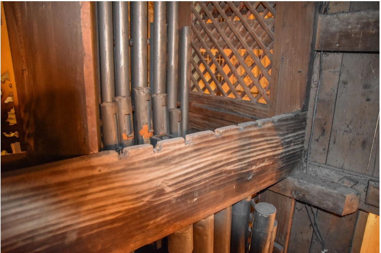
Fotografia 78 – pozostałości po wcześniejszej konstrukcji organów
