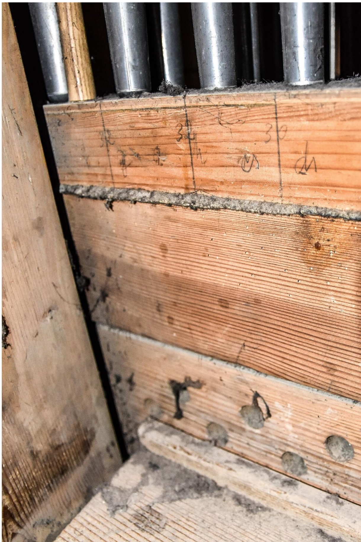
Fotografia 97 – wiatrownica manualu głównego z widocznymi: kanałem wiatrowym, listwą wałków popychaczy, uszczelnieniem, częścią główną z otworami będącymi śladami żeru owadźich szkodników drewna, literowymi i liczbowymi podpisami na górnej części wiatrownicy
