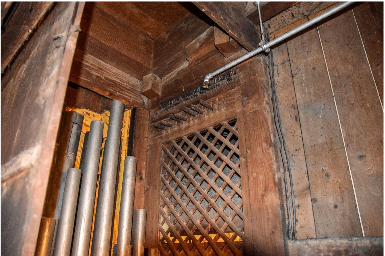
Fotografia 79 – zachowana listwa z kątownnikami, pozostałość po obecnie niemych pozytywie górnym
