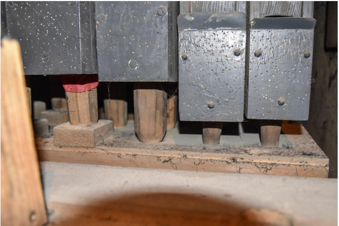
Fotografia 131 – odmienna forma nóg piszczałek drewnianych w sekcji pedałowej; ślady po żerowaniu drewnojadów w forszlagach
