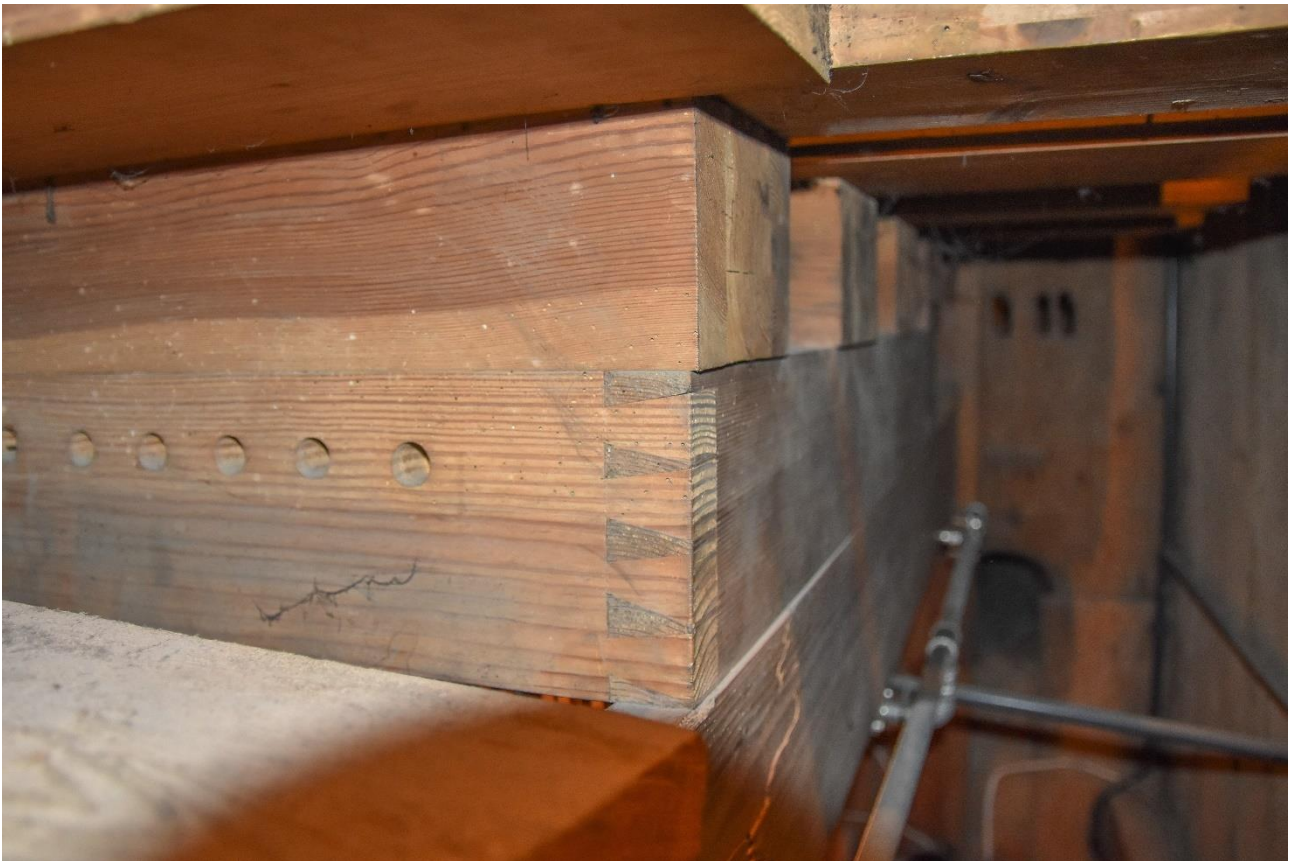
Fotografia 126 – wiatrownica stożkowa sekcji pedałowej, widoczne przegrody rejestrowe, połączenie na jaskółczy ogon w części dolnej, w tyle trzy otwory w szafie organowej pochodzące z instrumentu sprzed przebudowy wykonanej przez A. Żebrowskiego
