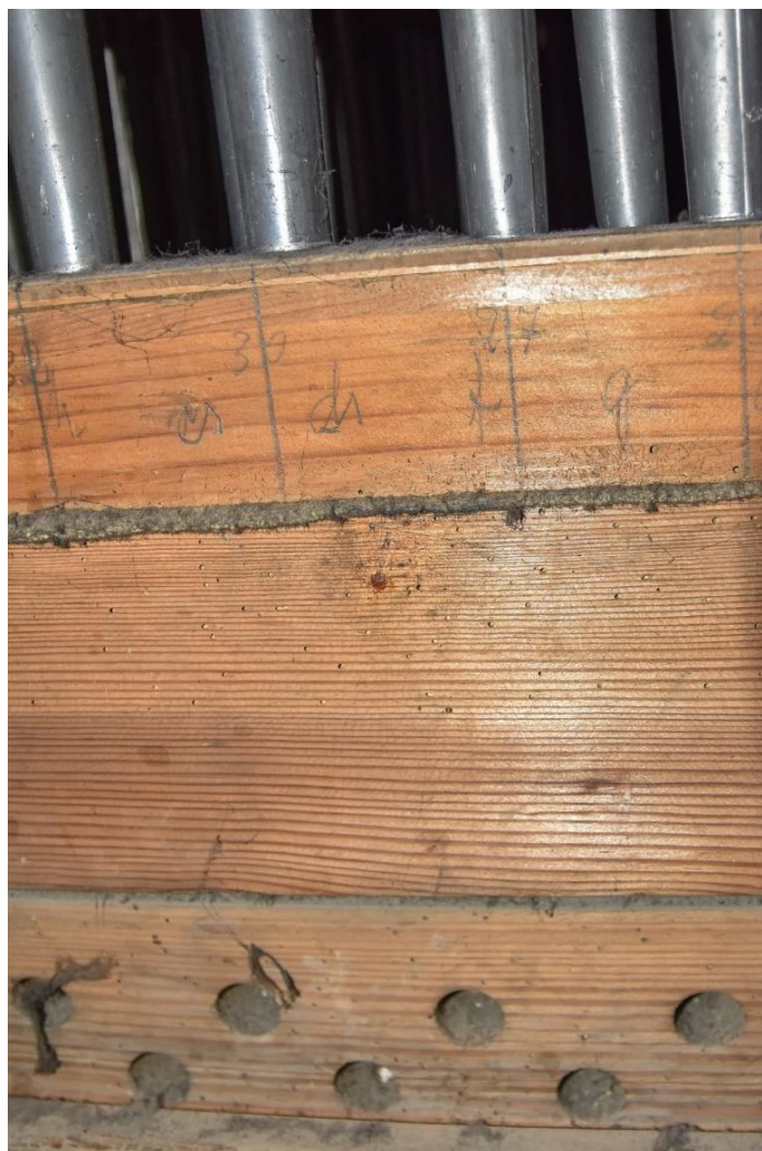
Fotografia 10 – wykonane ołówkiem podpisy tonów na górnej pokrywie wiatrownicy, w przegrodzie wiatrowej i otworach, w których osadzone są wałki tonowe widoczne ślady żeru drewnojadów
