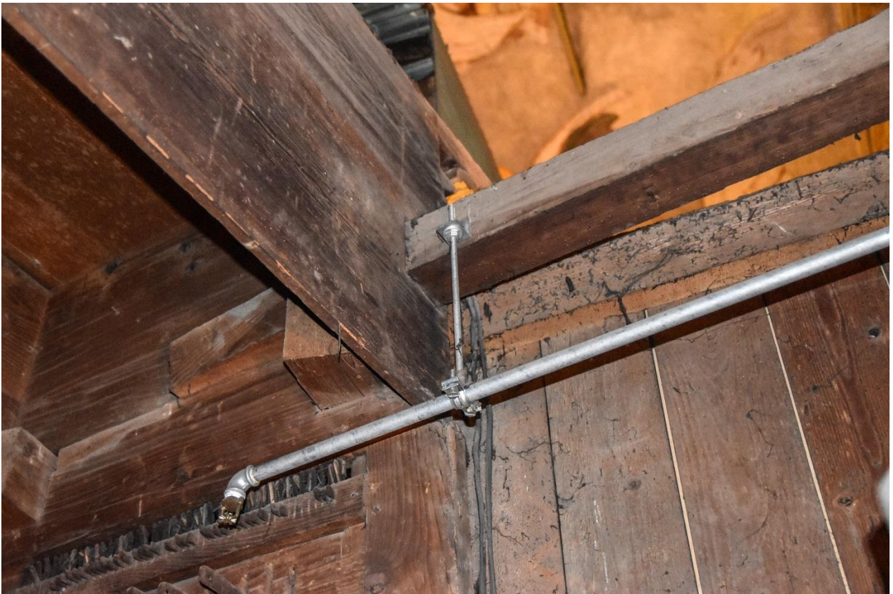
Fotografia 84 – rura systemu przeciwpożarowego kończąca się obok miejsca ulokowania listwy kątowników dawnego systemu traktury
