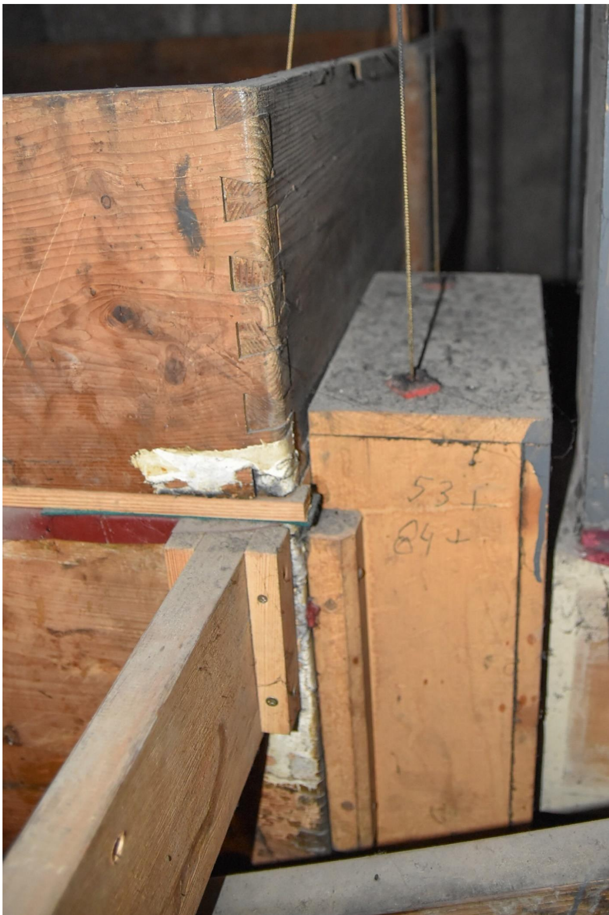
Fotografia 66 – skrzynka regulacyjna z zaciekiem farby i oznaczeniami liczbowymi umieszczona obok miecha złożonego z dwóch kondygnacji przedzielonych drewnianą listwą i kawałkiem filcu, widoczna różnica w jakości zastosowanego drewna pozwala odróżnić elementy oryginalne od wtórnych
