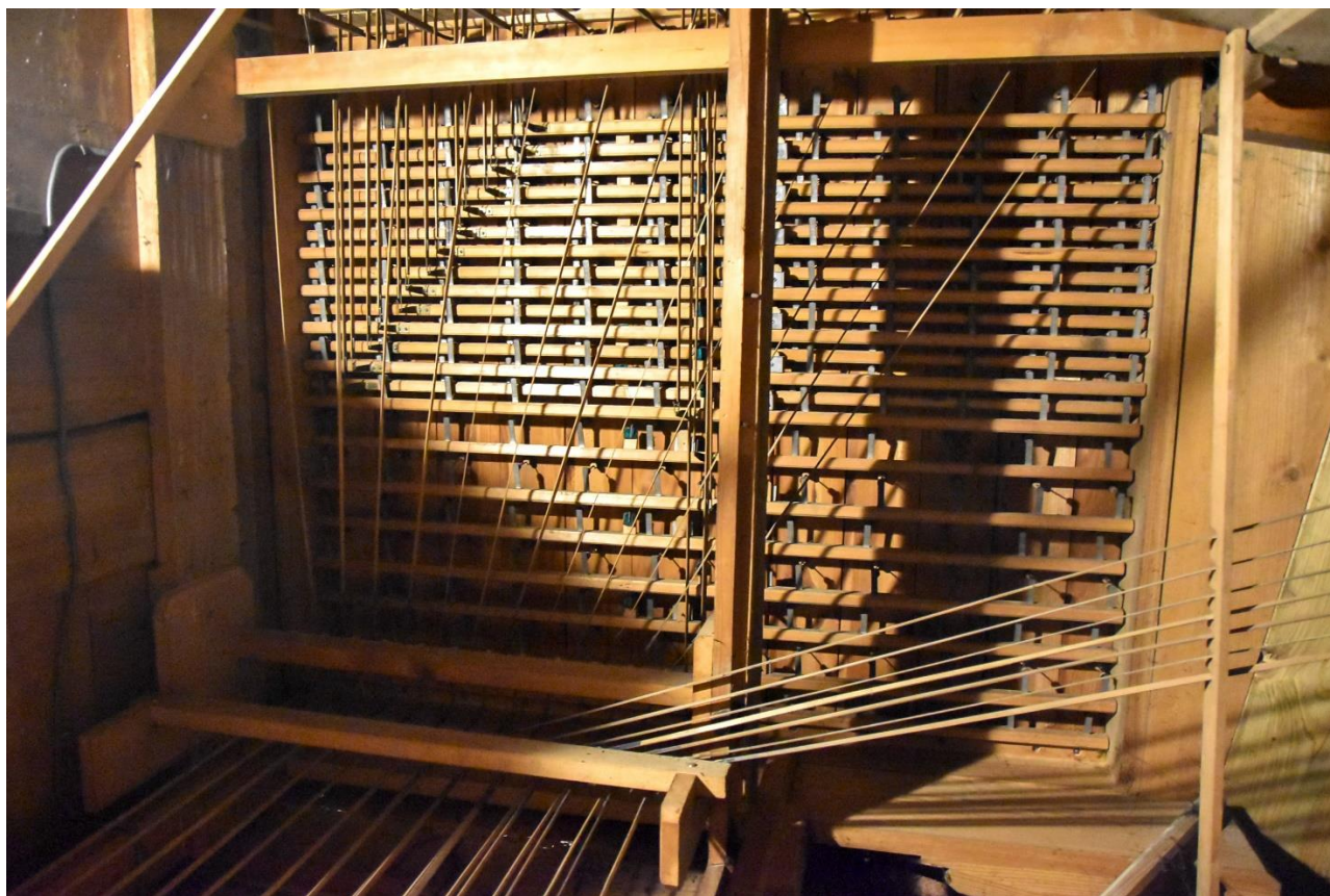
Fotografia 5 – widok z dołu: promieniste prowadzenie abstraktów, nad nimi spód wiatrownicy z widocznymi popychaczami zaworów stożkowych
