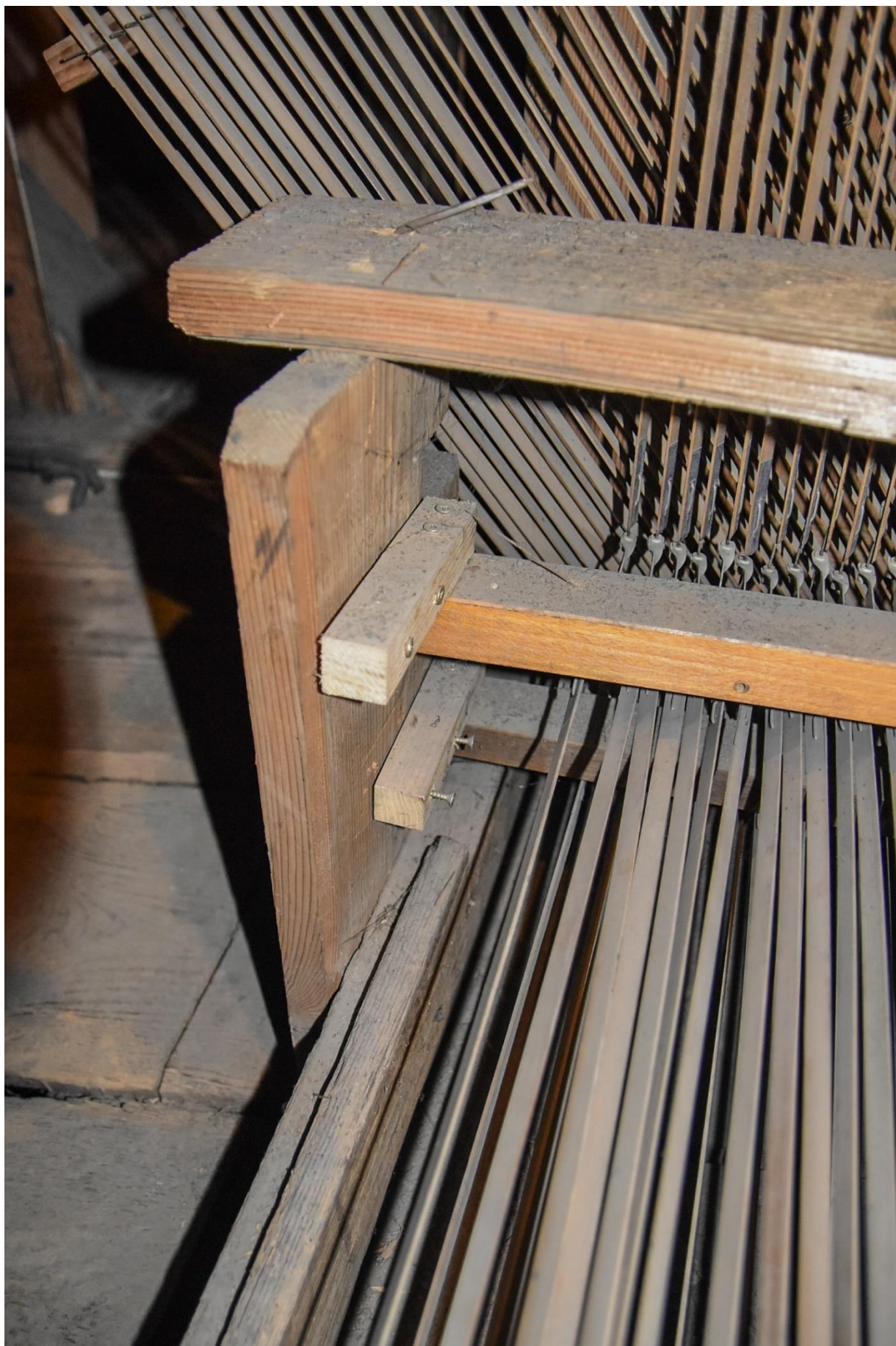
Fotografia 62 – początek ciągu traktowego, wykrzywione abstrakty, prowizoryczne mocowanie listew stabilizujących
