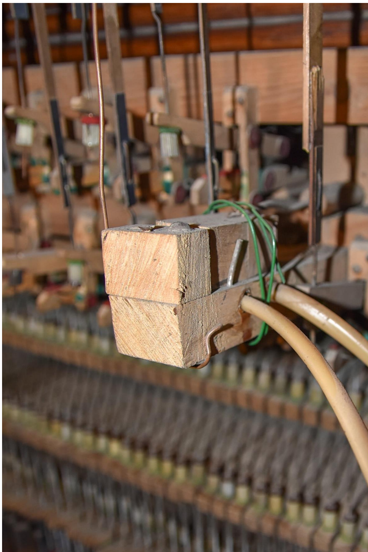
Fotografia 34 – włącznik mechanizmu tremola z odchodzącymi przewodami pneumatycznymi, specyficzny sposób montażu
