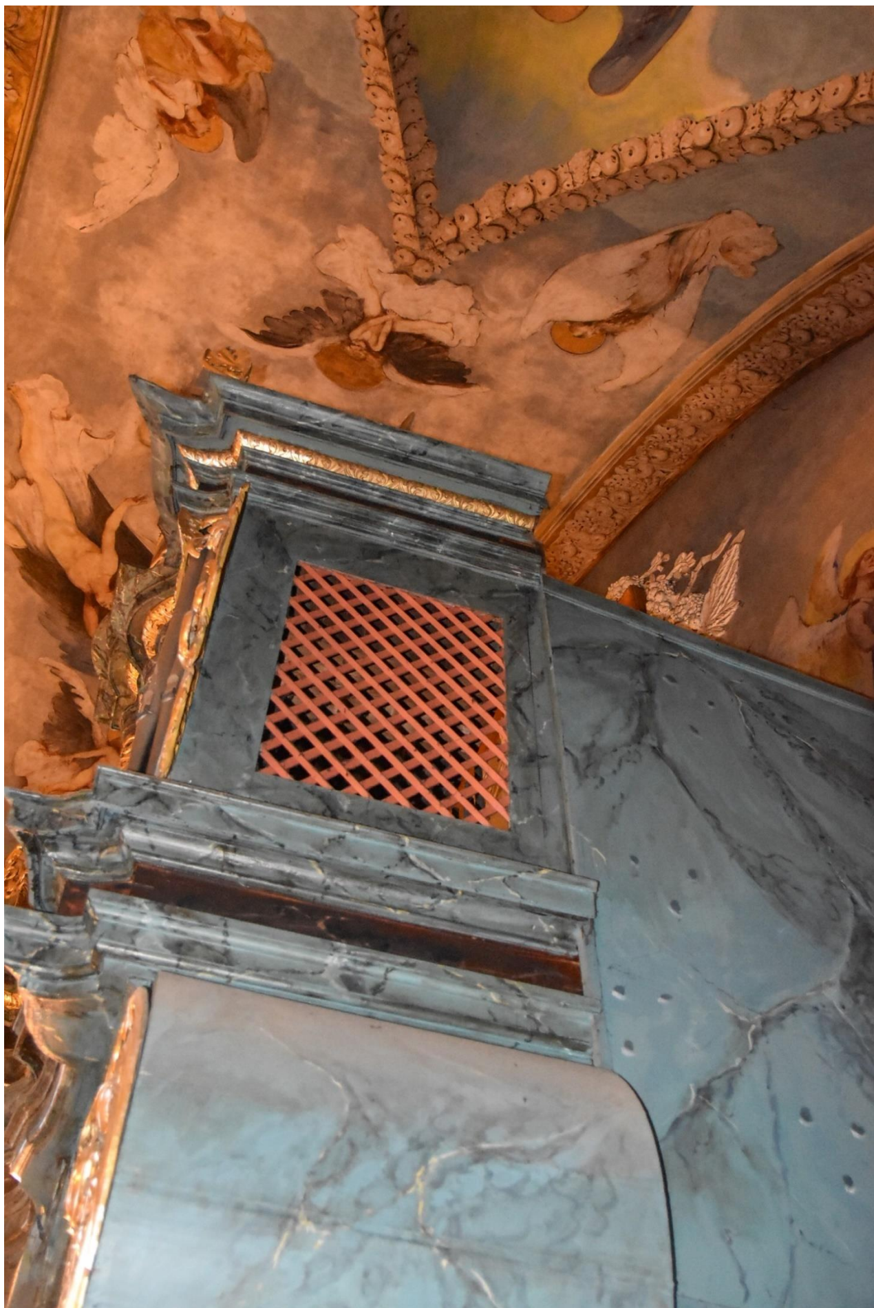
Fotografia 30 – kratownica, widok od strony szafy północnej w kierunku południowym
