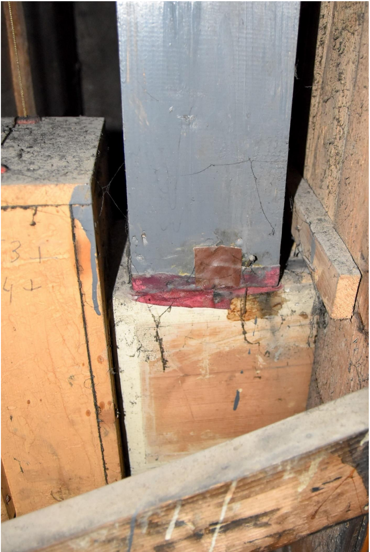
Fotografia 67 – połączenie skrzynki regulacyjnej i kanału, widoczne trzy warstwy prób uszczelnienia za pomocą materiałów skóropodobnych
