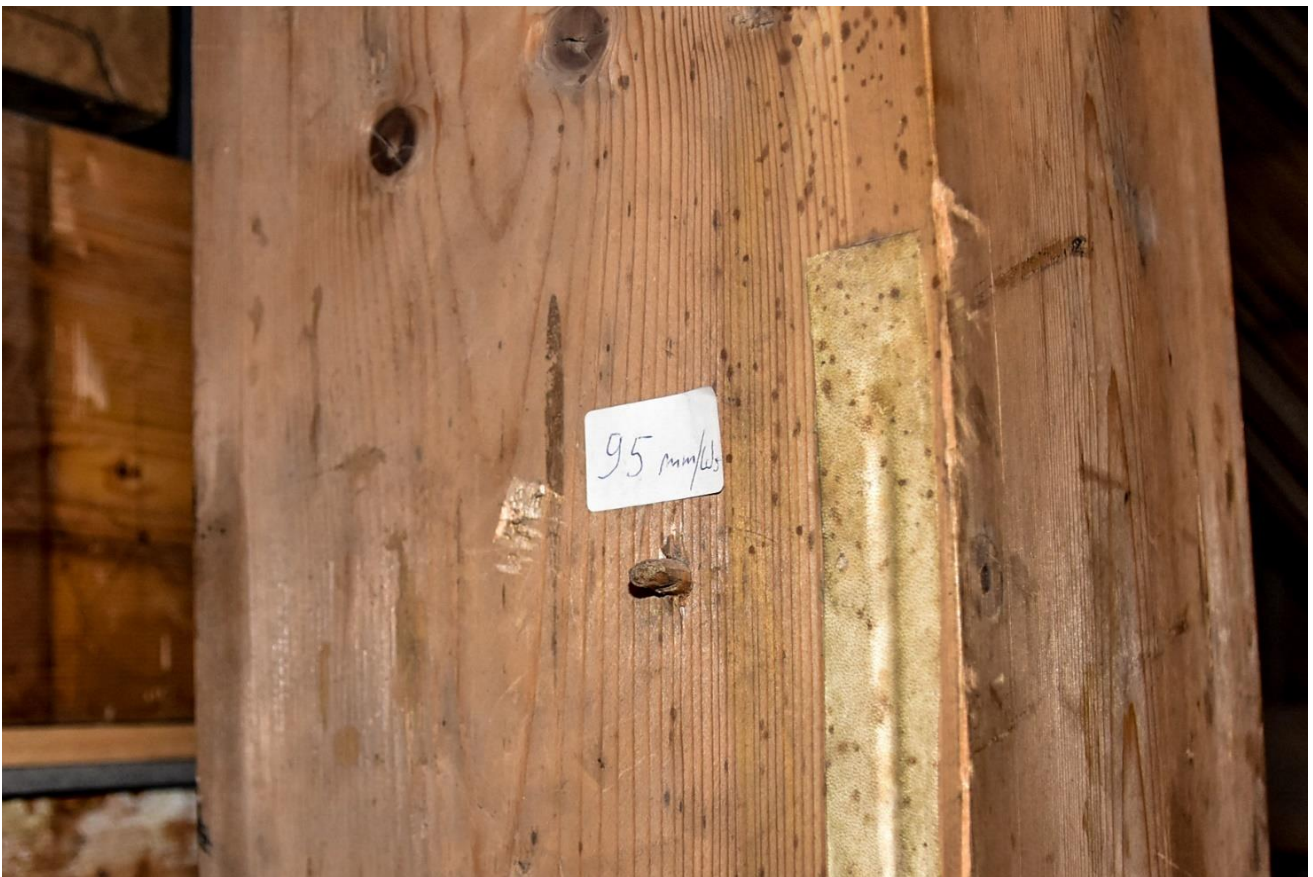
Fotografia 49 – punkt kontrolny ciśnienia wiatru w kanale powietrznym
