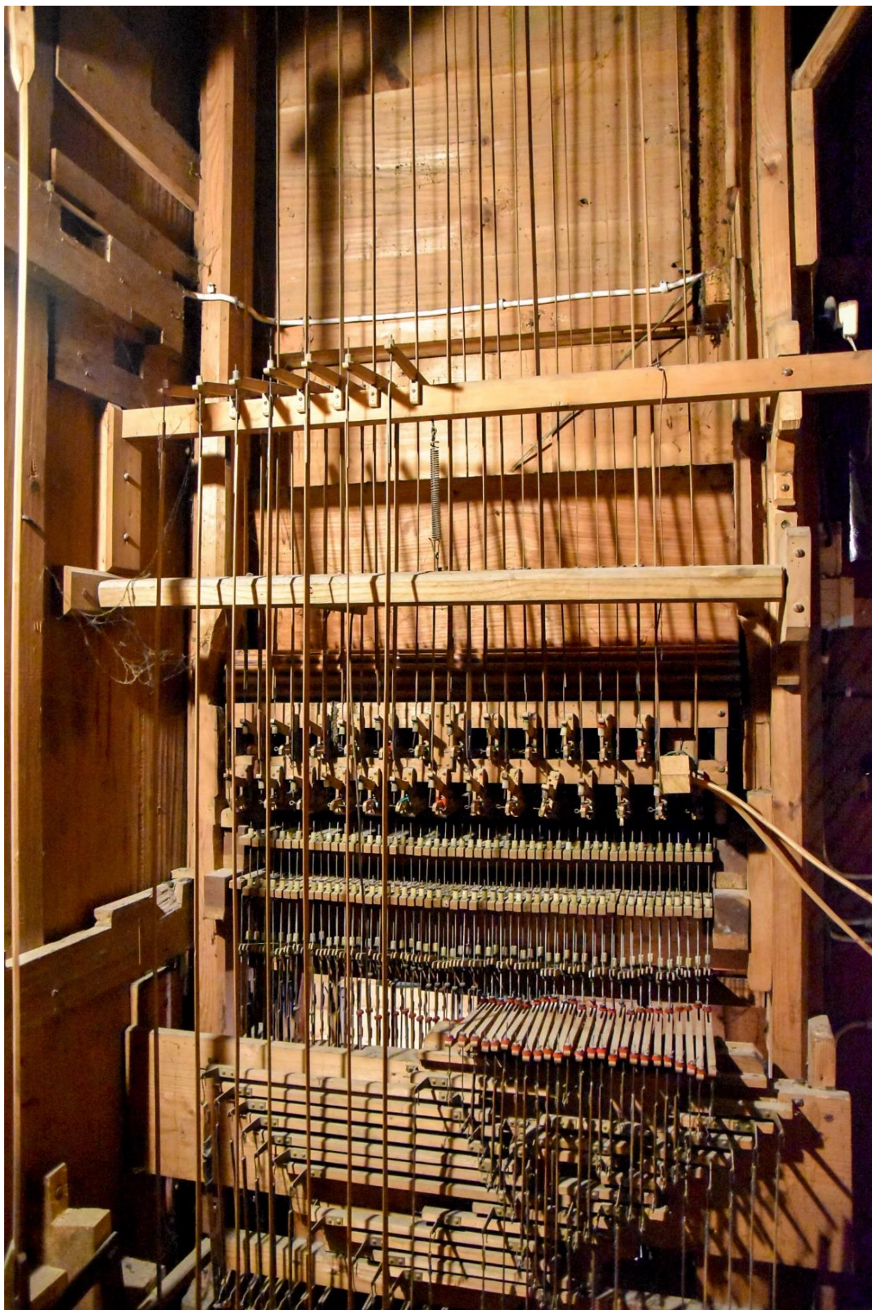
Fotografia 7 – początek traktury widoczny od tylnej strony kontuaru, zauważalny brak wyregulowania i wypoziomowania poszczególnych elementów, użycie plastikowych muterek oraz prowizorycznie ustabilizowany za pomocą owinięcia kablem włącznik tremulantu z odchodzącymi przewodami do aparatu tremolo
