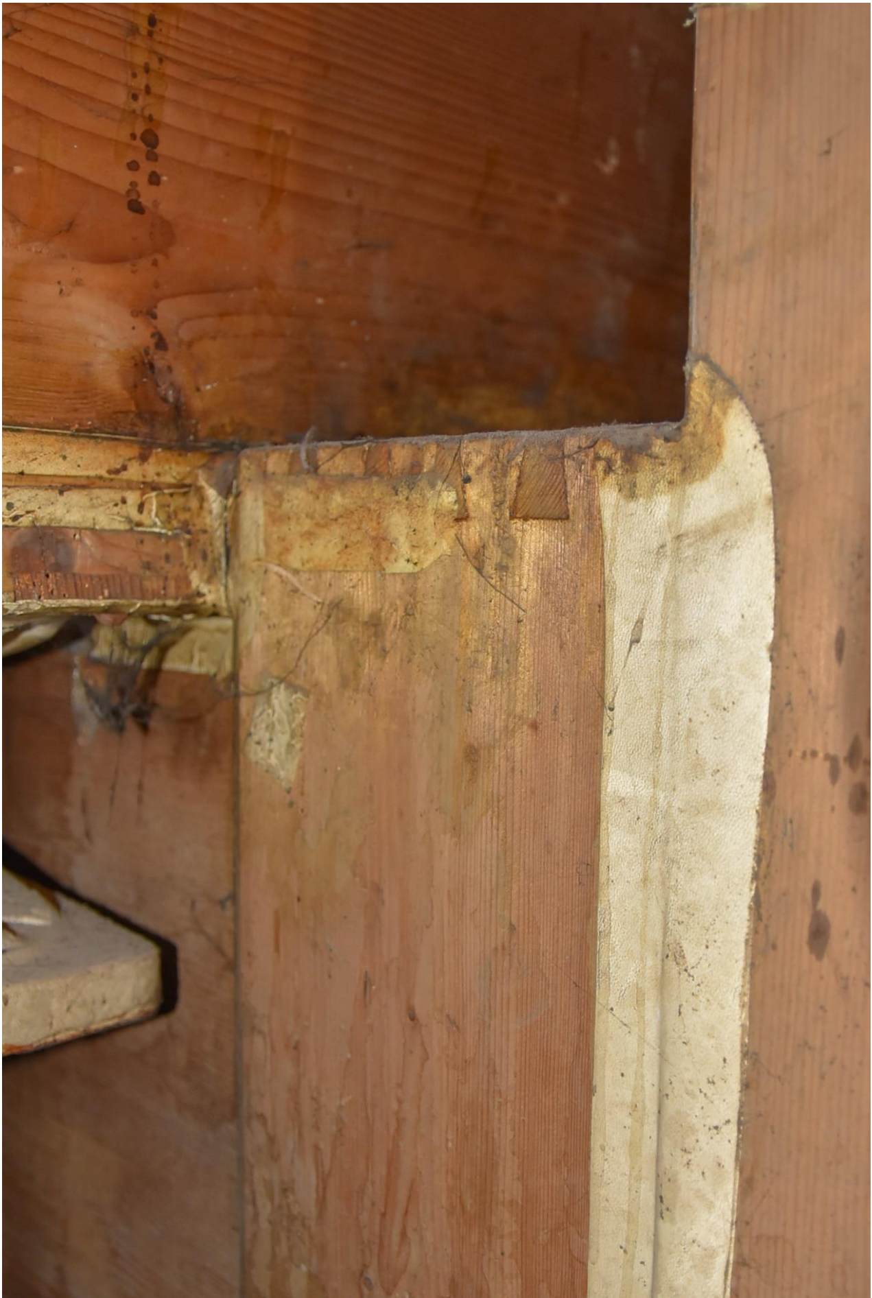
Fotografia 50 – połączenie miecha z kanałem wiatrowym
