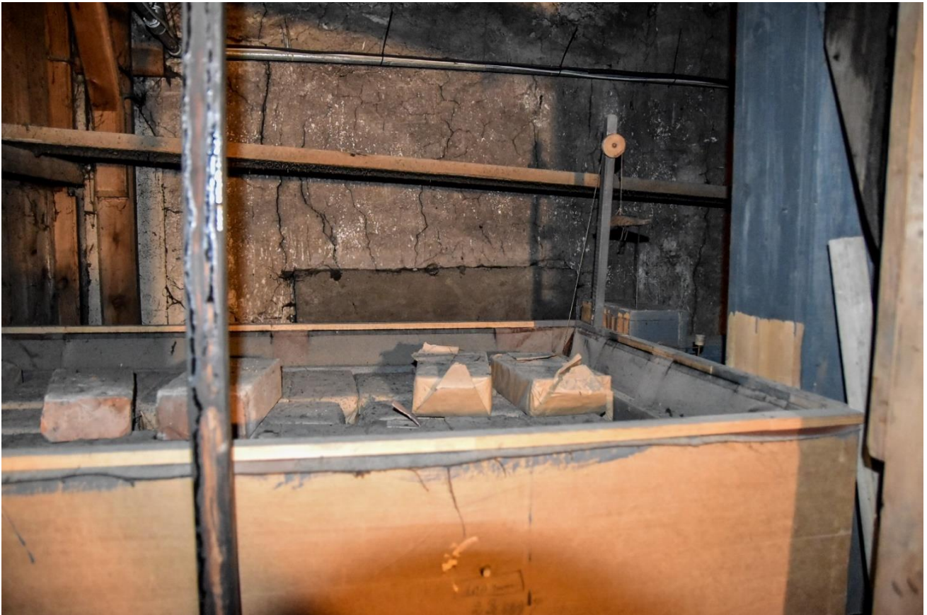
Fotografia 44 – wierzchnia część miecha pływającego z częścią opakowanych i nieopakowanych obciążników, widoczna w braku malowania kanał powietrzny zmiana usytuowania skrzynki regulacyjnej
