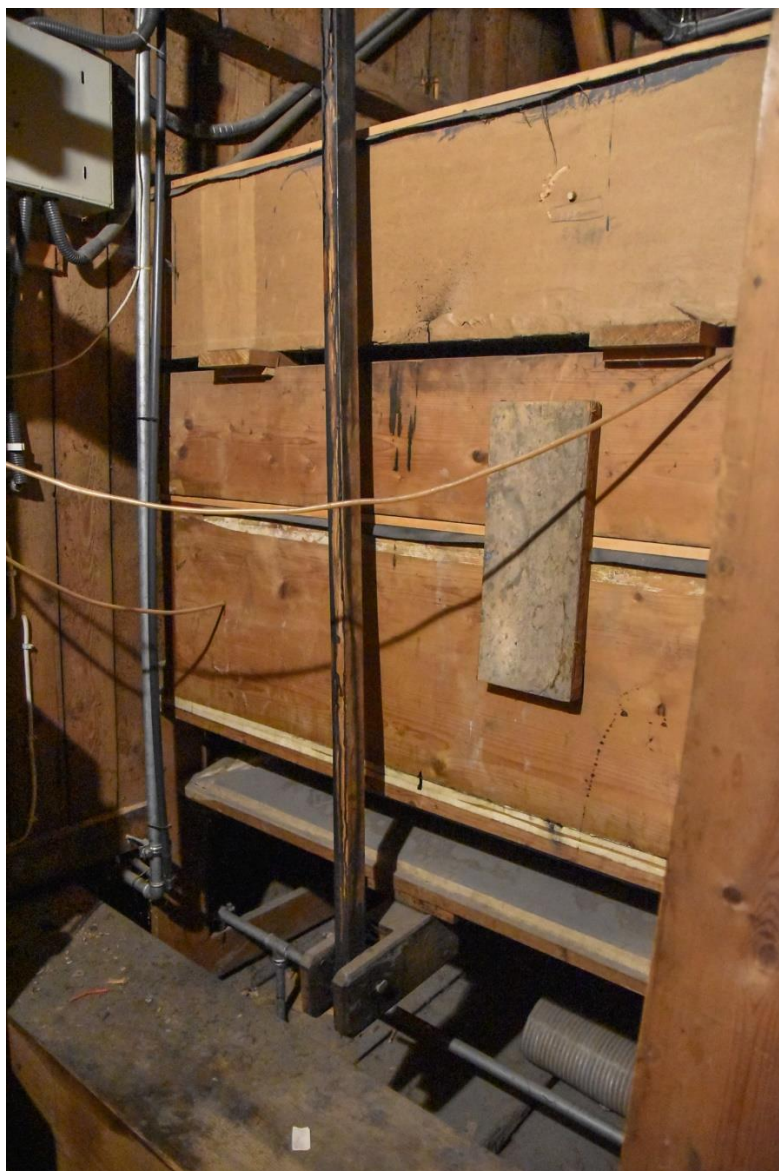
Fotografia 1 – miech pływakowy umieszczony w szafie północnej wyposażony w klinowy czerpak; zauważalna zmiana konstrukcji podczas jednego z przeprowadzonych remontów, górna skrzynia dostawiona na drewnianych deskach pełniących funkcję wsporników ustawionych poprzecznie
