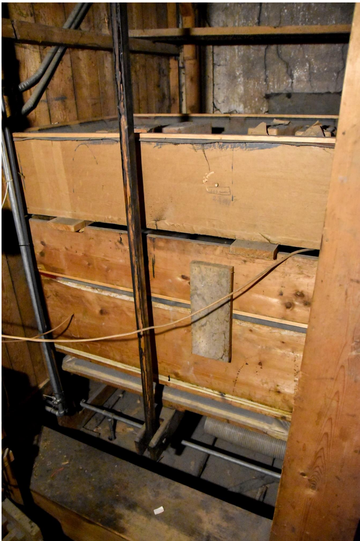
Fotografia 45 – miech, widoczne cztery elementy: czerpak z dźwignią kalikancką równoległą do rury przeciwpożarowej, dolna skrzynka przedzielona na dwie części, górny miech pływakowy z obciążnikami ustawiony na dwóch drewnianych deskach, po demontażu górnej części możliwe będzie sprawdzenie stanu dolnych struktur oraz stwierdzenie warstwy oryginalnej i wtórnej zastosowanych rozwiązań
