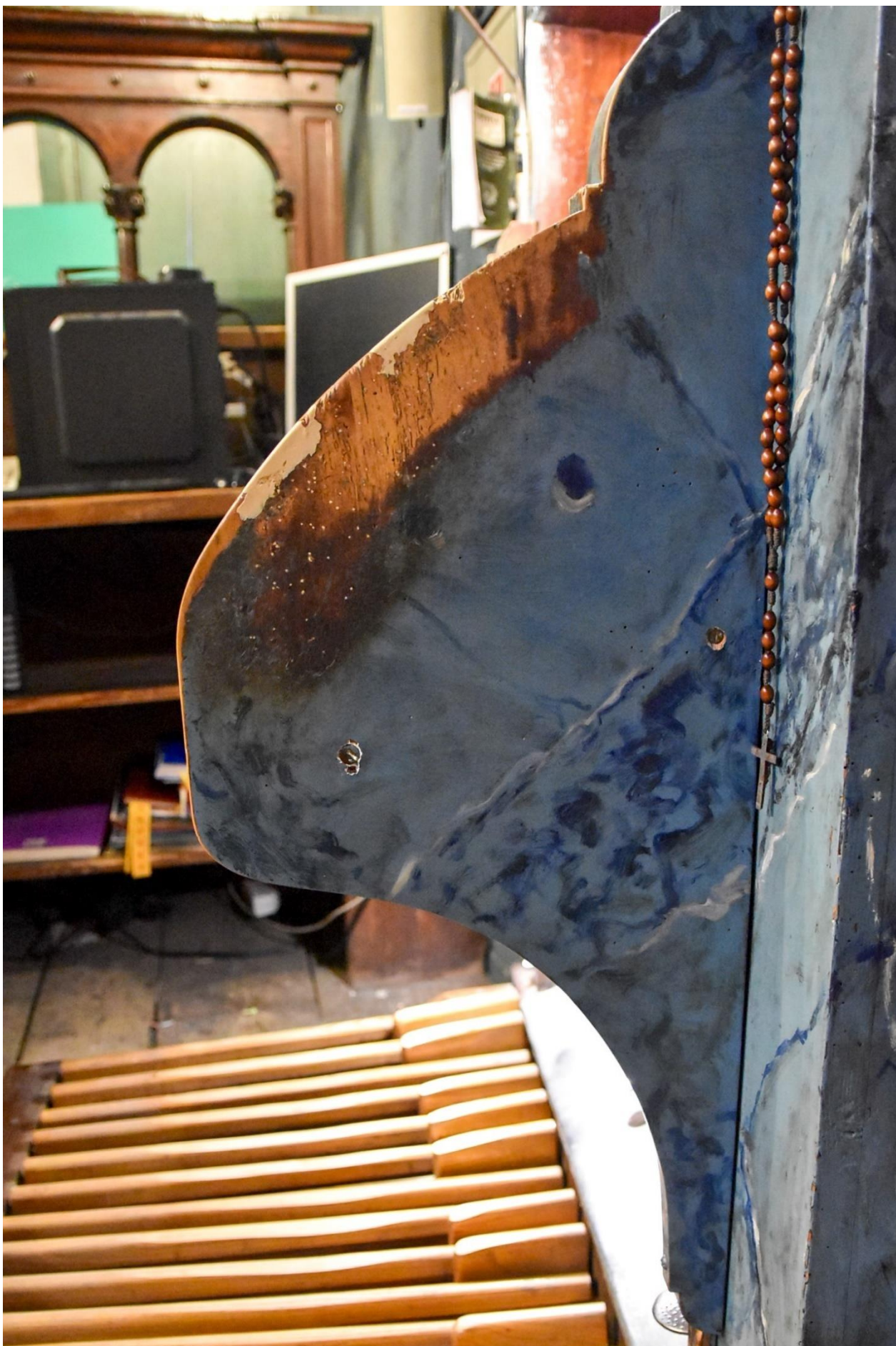
Fotografia 21 – prawy bok stołu gry, drewniane ubytki uzupełnione szpachlą
